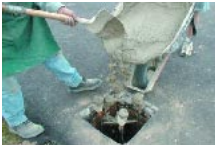
Figure 7 Pour The Concrete
